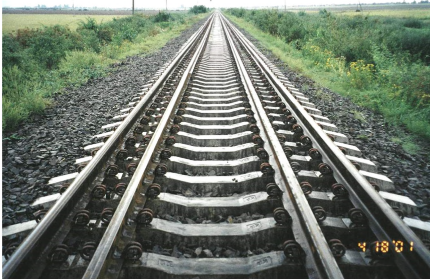
Рис. 4 – Новый участок совмещенной рельсовой колеи 1520 и 1435 мм
